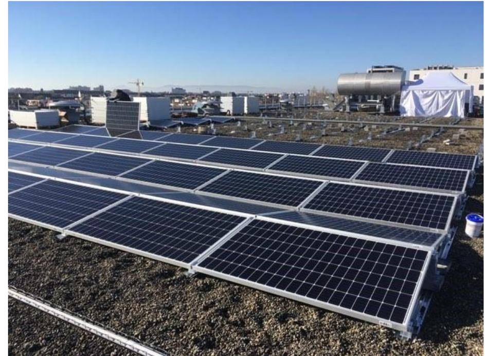
*Grutage pour approvisionnement matériel et pose des panneaux (E/O structure lestée)*
