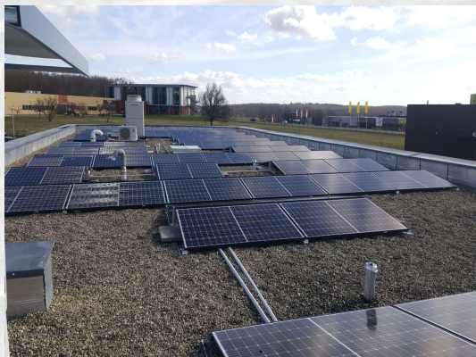
Ecole des Sources 36kWc, 180m 2 de PV
