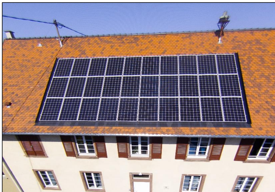
Mairie-école de Thal-Marmoutier 9kWc, 55 m 2 de panneaux
