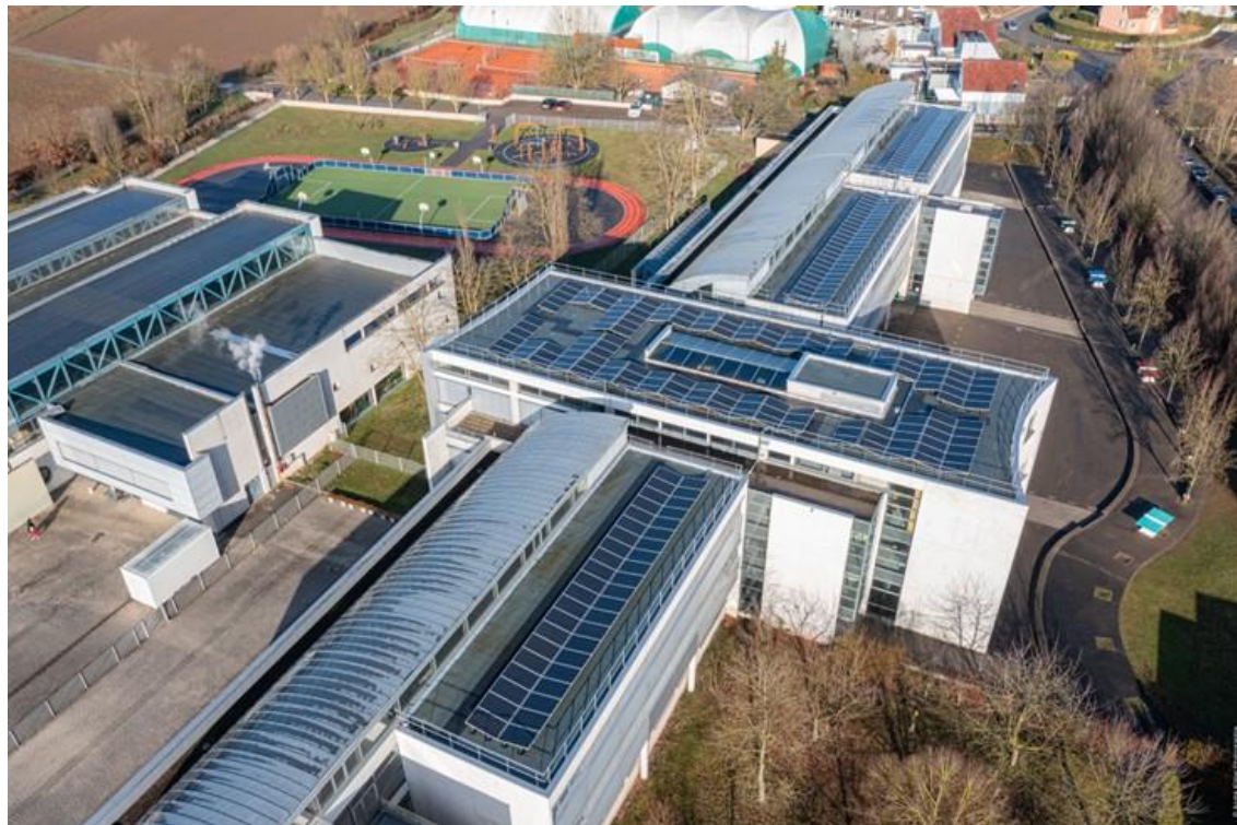
Collège de Truchtersheim 2022 – 94 kWc
